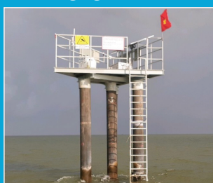
Trạm đo gió trên biển cách bờ 10km (công nghệ LIDAR)
