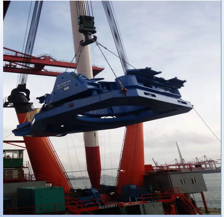
香港葵涌码头吊装工程 (2019) Lifting Installation at Kwai Chung Ferry Pier, HK
