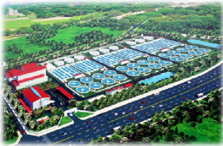
Viet Tri waste water treatment plant - Phu Tho, Vietnam (Nhà máy thu gom xử lý nước thải Việt Trì - Phú Thọ, Việt Nam)
