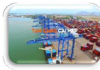
Cai Mep seaport Vung Tau, Vietnam
