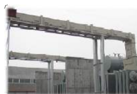
NSPB (Hệ thống thanh dẫn)
