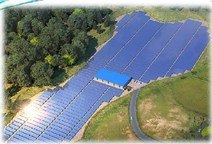
Yeongam Solar Power Plant 93MW – Korea (Nhà máy điện mặt trời Yeongam 93MW – Hàn Quốc)
