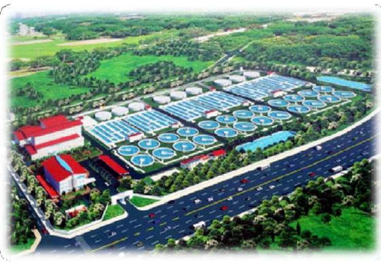
Viet Tri waste water treatment plant - Phu Tho, Vietnam (Nhà máy thu gom xử lý nước thải Việt Trì - Phú Thọ, Việt Nam)
