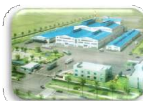
Lock&Lock Vina Vung Tau, Vietnam
