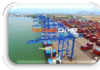
Cai Mep seaport Vung Tau, Vietnam
