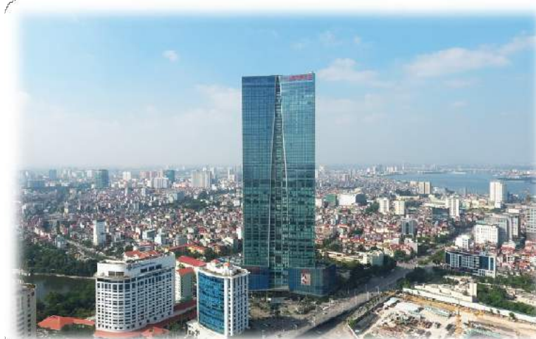
Lotte Centre Hanoi, Vietnam (Tòa nhà Lotte Centre Hanoi, Việt Nam)
