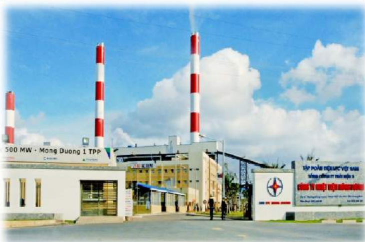
Mong Duong Thermal Power Plant 1,2 (2320MW) Nhà máy nhiệt điện Mông Dương 1,2 (2320MW)
