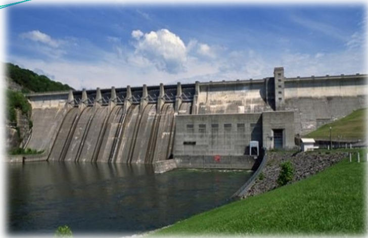
Ham Thuan - Dami hydro power plant (Binh Thuan) 300MW Nhà máy thủy điện Hàm Thuận – Đa Mi (Bình Thuận), 300MW
