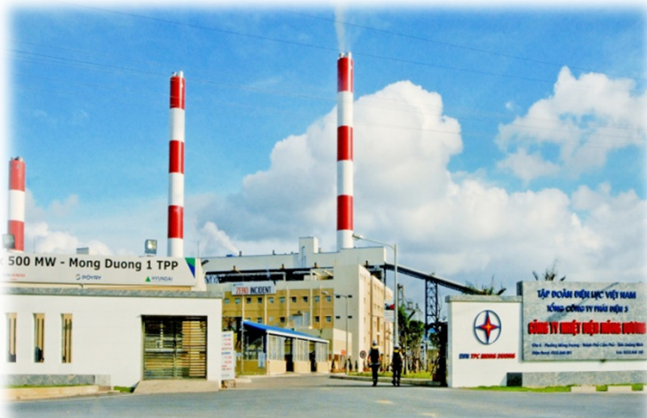
Mong Duong Thermal Power Plant 1,2 (2320MW) Nhà máy nhiệt điện Mông Dương 1,2 (2320MW)
