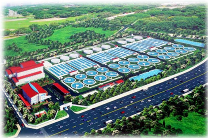
Viet Tri waste water treatment plant - Phu Tho, Vietnam (Nhà máy thu gom xử lý nước thải Việt Trì - Phú Thọ, Việt Nam)
