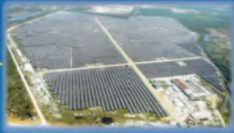
Phong Điện II Solar Power Plant (50MWp)
