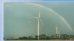
Yang Trung Wind Power Plant (145MW)
